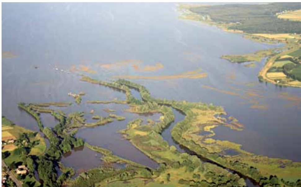
Fot. 3. Widok na ujście Wisły do zbiornika Goczałkowickiego, lipiec 2006, foto. A. Siudy
