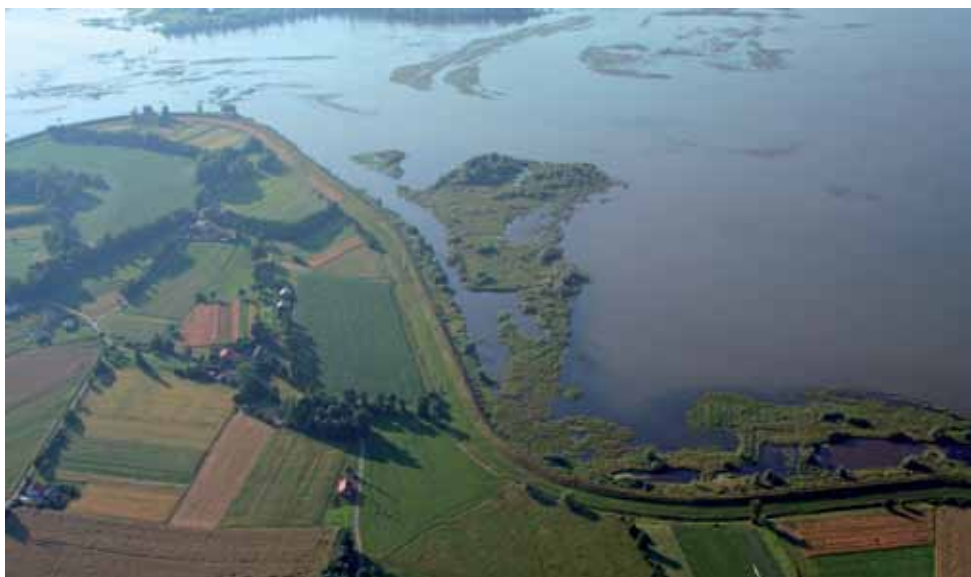
Fot. 6. Widok na tzw. Stokłosówkę na Zbiorniku Goczałkowickim, lipiec 2006, foto. A. Siudy
