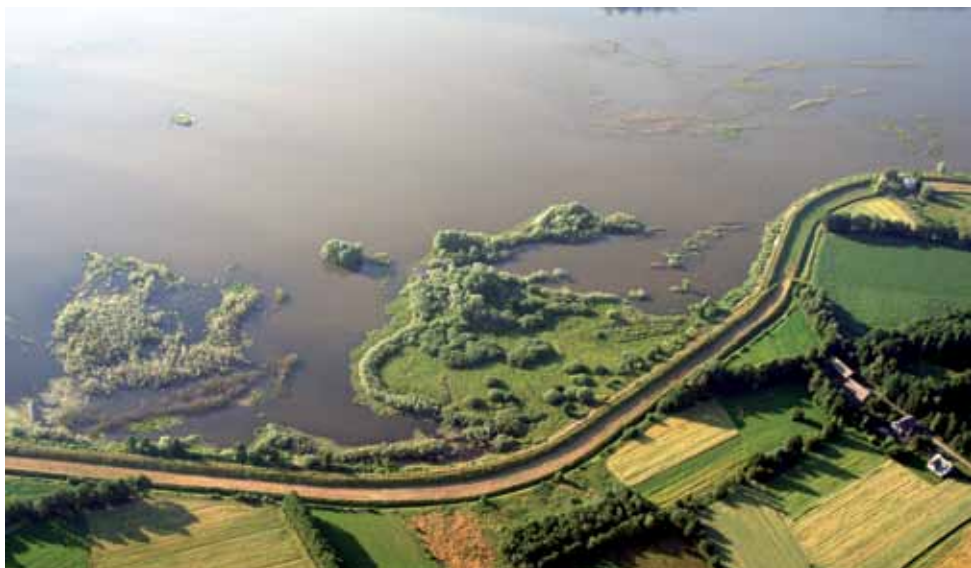
Fot. 5. Widok na tzw. Dziury i przepompownię Frelichów na Zbiorniku Goczałkowickim, lipiec 2006, foto. A. Siudy
