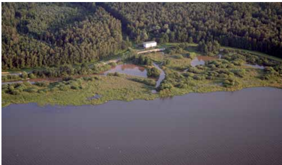
Fot. 7. Widok na przepompownię Zarzecze na zbiorniku Goczałkowickim, lipiec 2006, foto. A. Siudy Photo 7. View at the pumping-station „Zarzecze” at the Goczałkowice Reservoir, July 2006, photograph by A. Siudy
